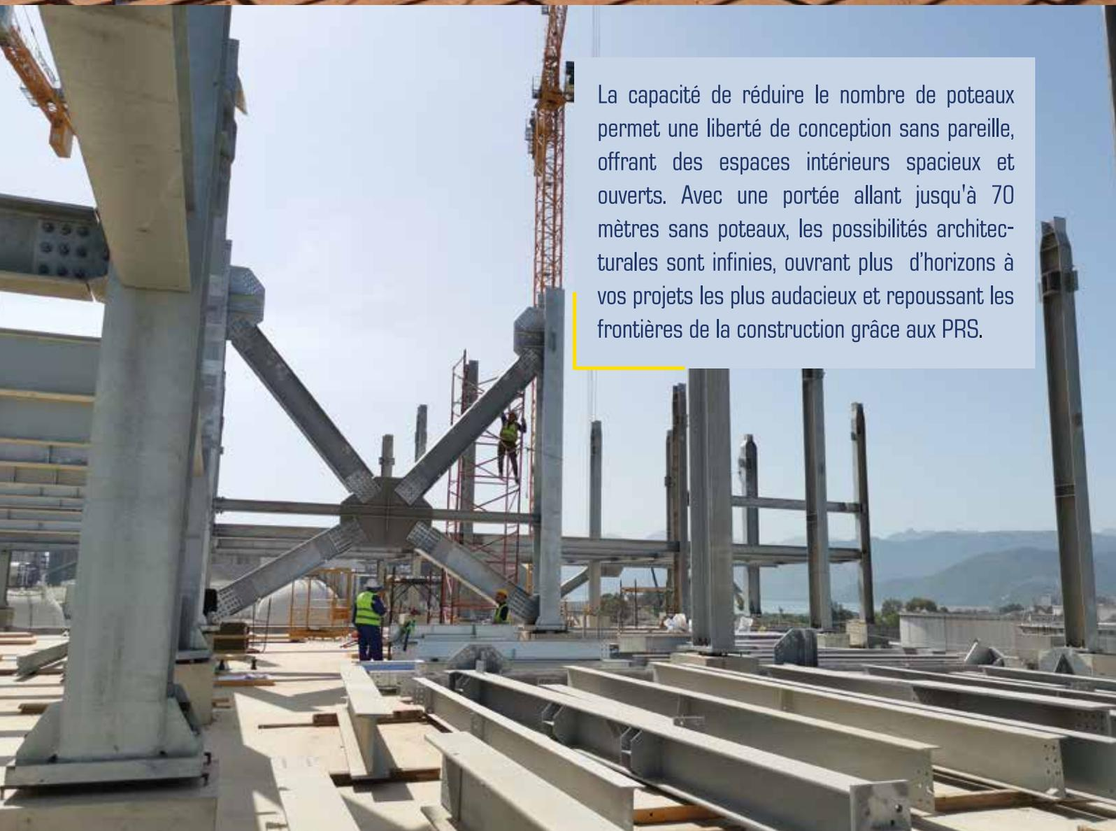
La capacité de réduire le nombre de poteaux permet une liberté de conception sans pareille, offrant des espaces intérieurs spacieux et ouverts. Avec une portée allant jusqu'à 70 mètres sans poteaux, les possibilités architecturales sont infinies, ouvrant plus d'horizons à vos projets les plus audacieux et repoussant les frontières de la construction grâce aux PRS.
